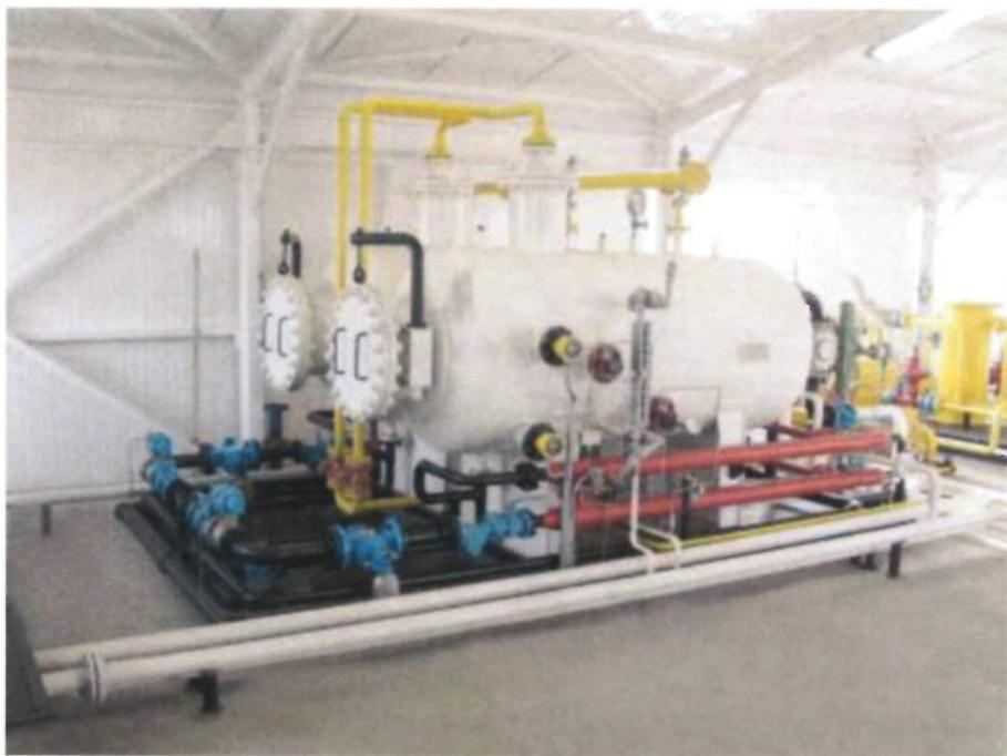
Măsurarea presiunii în separator se face cu ajutorul manometrelor cu tub Bourdon.
